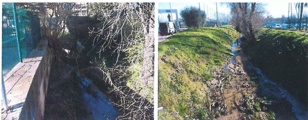
Figure 11 : Vallon de la Vernède en amont (à gauche) et en aval (à droite) de l'Avenue du Général Garbay
