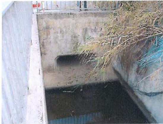
Figure 9 : Vallon des Crottes à ciel ouvert (dégraveur) au croisement de l'Avenue du Général Garbay et de la Rue de Bocri
