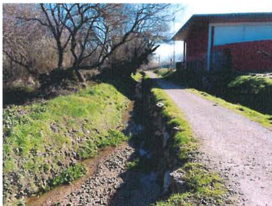
Figure 10 : Vallon du Gabron en aval de l'Avenue du Général Garbay
