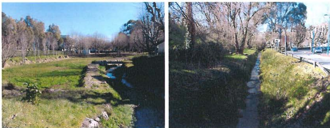
Figure 13 : Vallon de la Théoulière à l'aval de son passage en souterrain – Présence du bassin de rétention en RG (à gauche) et à l'amont de son passage sous l'A8 (à droite)
